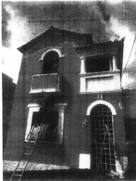
Fachada Principal Fonte: Acervo Técnico (2024)
